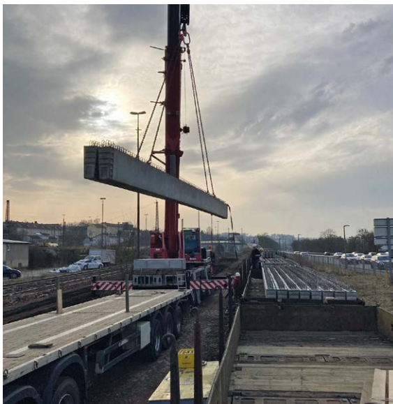
Beladung mittels Autokran am Passauer Hauptbahnhof.
