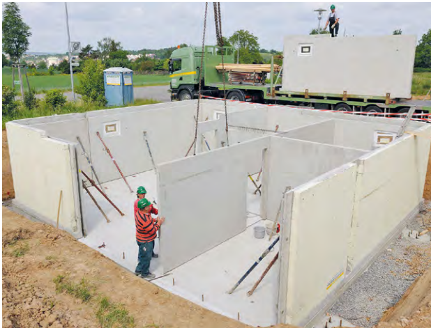
Unterkellerung schafft zusätzlichen Wohnraum.
