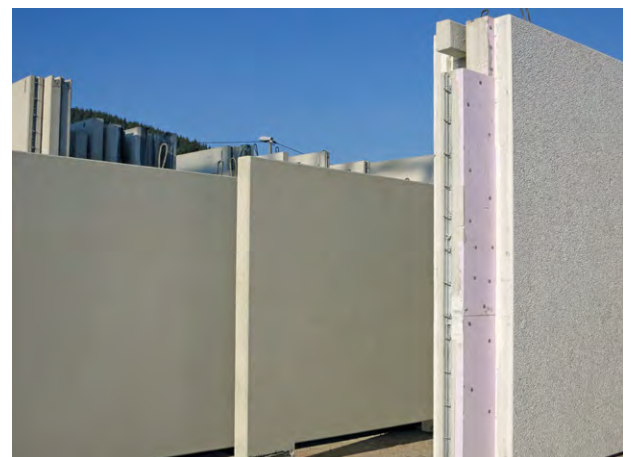
Sandwichwand mit zwei Betonschalen und innen liegender Wärmedämmung.
