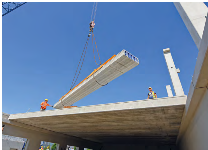
Verlegung einer Spannbetonfertigdecke.
