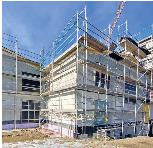
Der komplette Rohbau wurde im März 2021 fertiggestellt.
