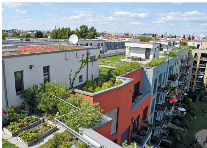
Gemeinschaftsdachgarten mit multifunktionaler Nutzung in Berlin. Regenwasserspeicher, Verdunstung, zusätzliche Nutzflächen für die Bewohnenden.
