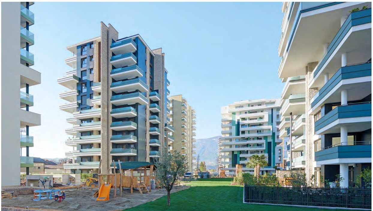
Bei diesem Geschosswohnungsbau in Brixen kamen Thermowände und Klimadecken zum Einsatz. Sie sorgen im Sommer und Winter für ein behagliches Raumklima.
