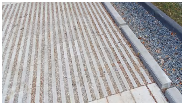
Beispiel für eine versickerungsfähige Pflasterdecke mit zusätzlicher Entwässerungseinrichtung in Form eines Mulden-Rigolen-Systems.
