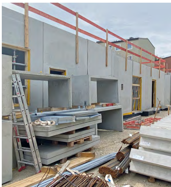
Die Lieferung und Montage der Betonfertigteile erfolgte im August 2020.
