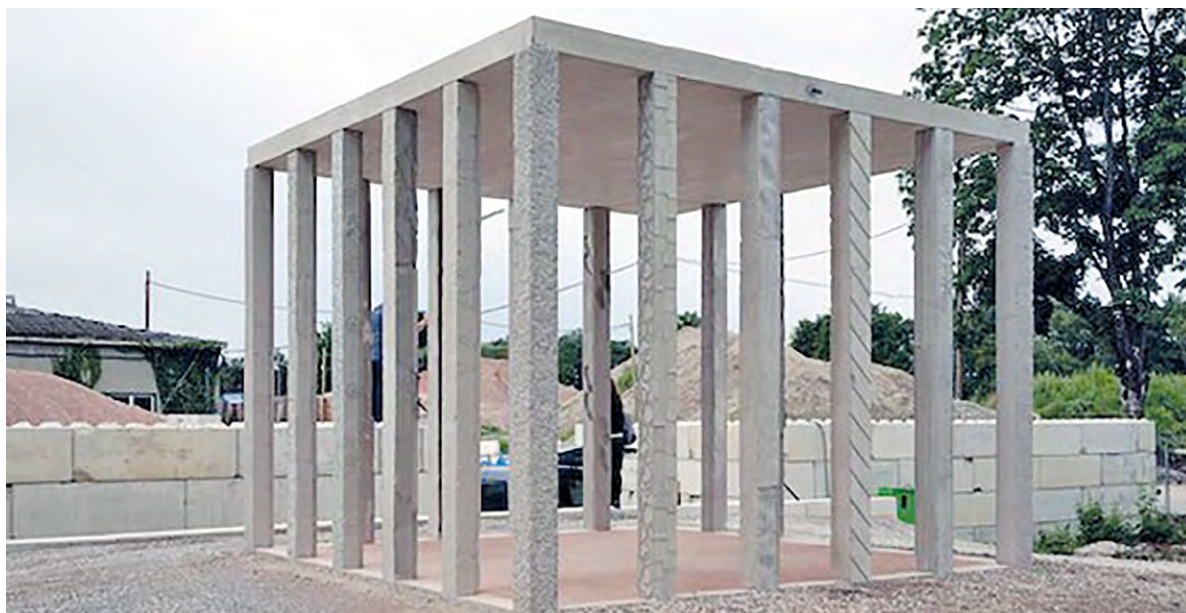
Der Pavillon zeigt selbstbewusst die Bandbreite der Gestaltungsmöglichkeiten des Recyclingbetons.
