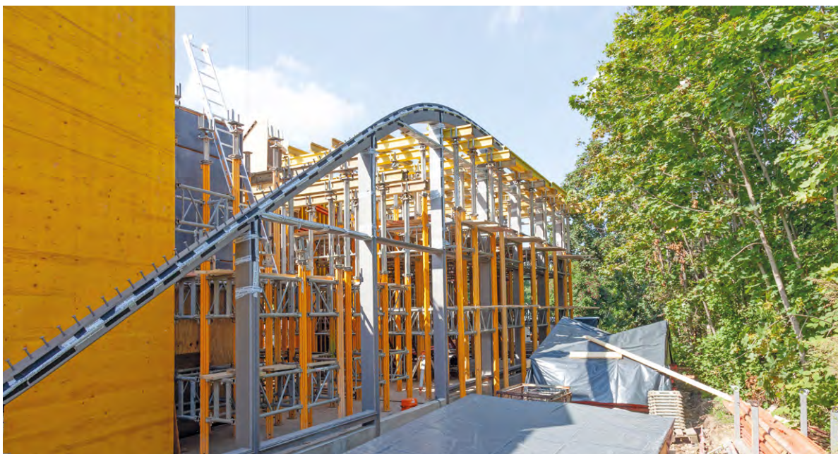
Aufbau der TWIST-Schalung.
