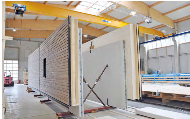
Werkseitige Herstellung der Hybridwand in Holz-Beton-Verbund.
