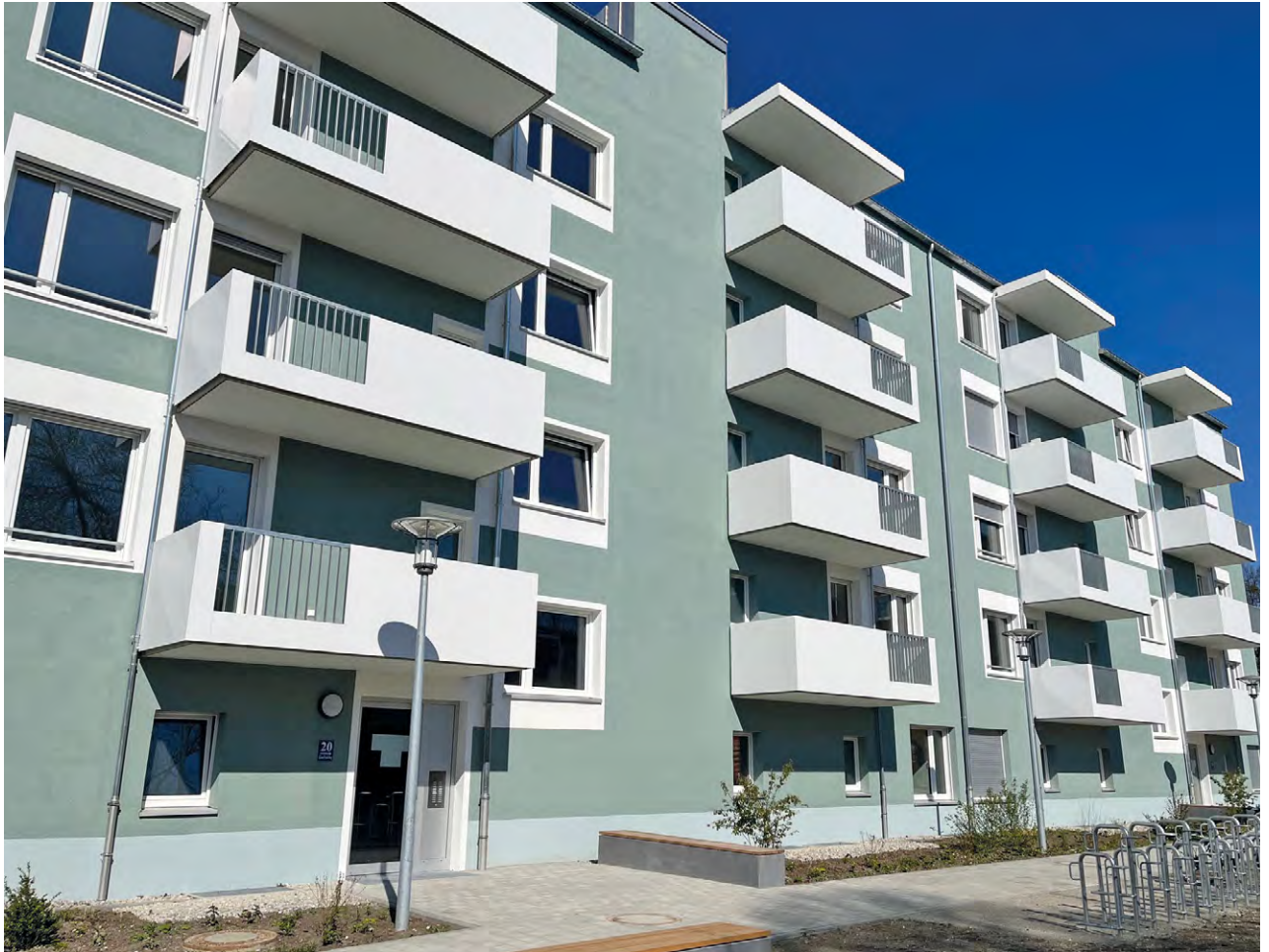
März 2021: Der Rohbau ist komplett.
