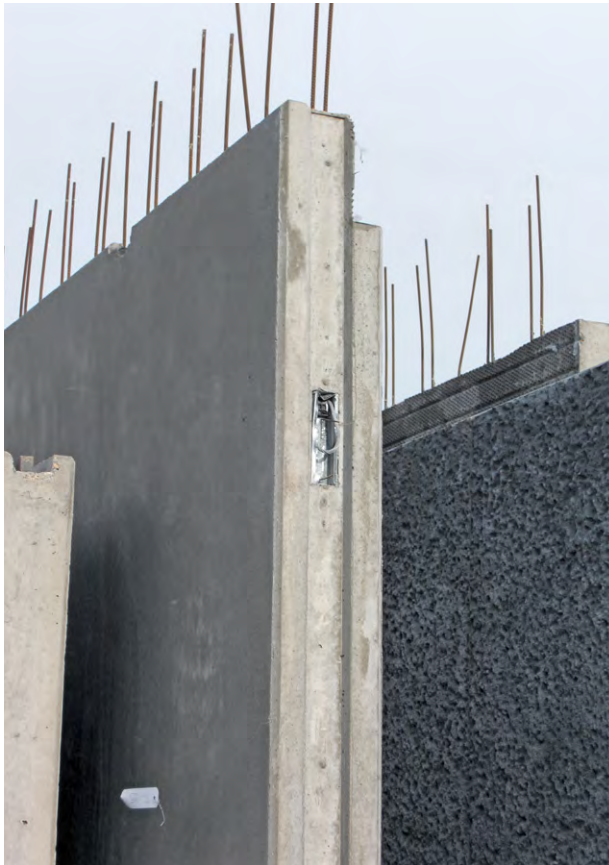
Massive Wandelemente mit Anschlussbewehrung.
