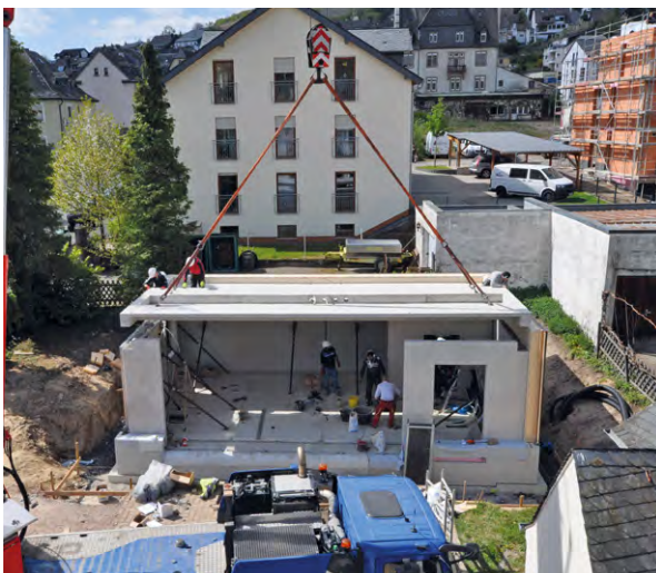
Montage der weitgespannten Deckenplatte für eine Moduleinheit.
