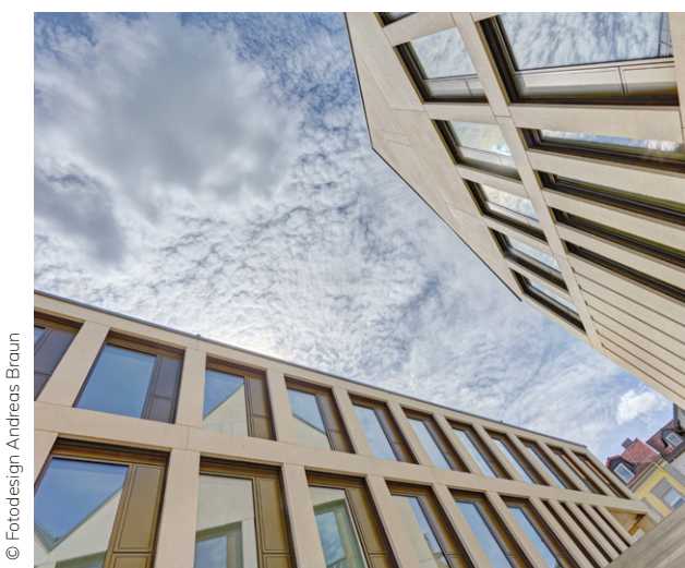
Das Rathaus in Korbach mit seiner Recycling-Betonfassade.
