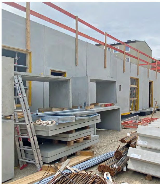
Die Lieferung und Montage der Betonfertigteile erfolgte im August 2020.
