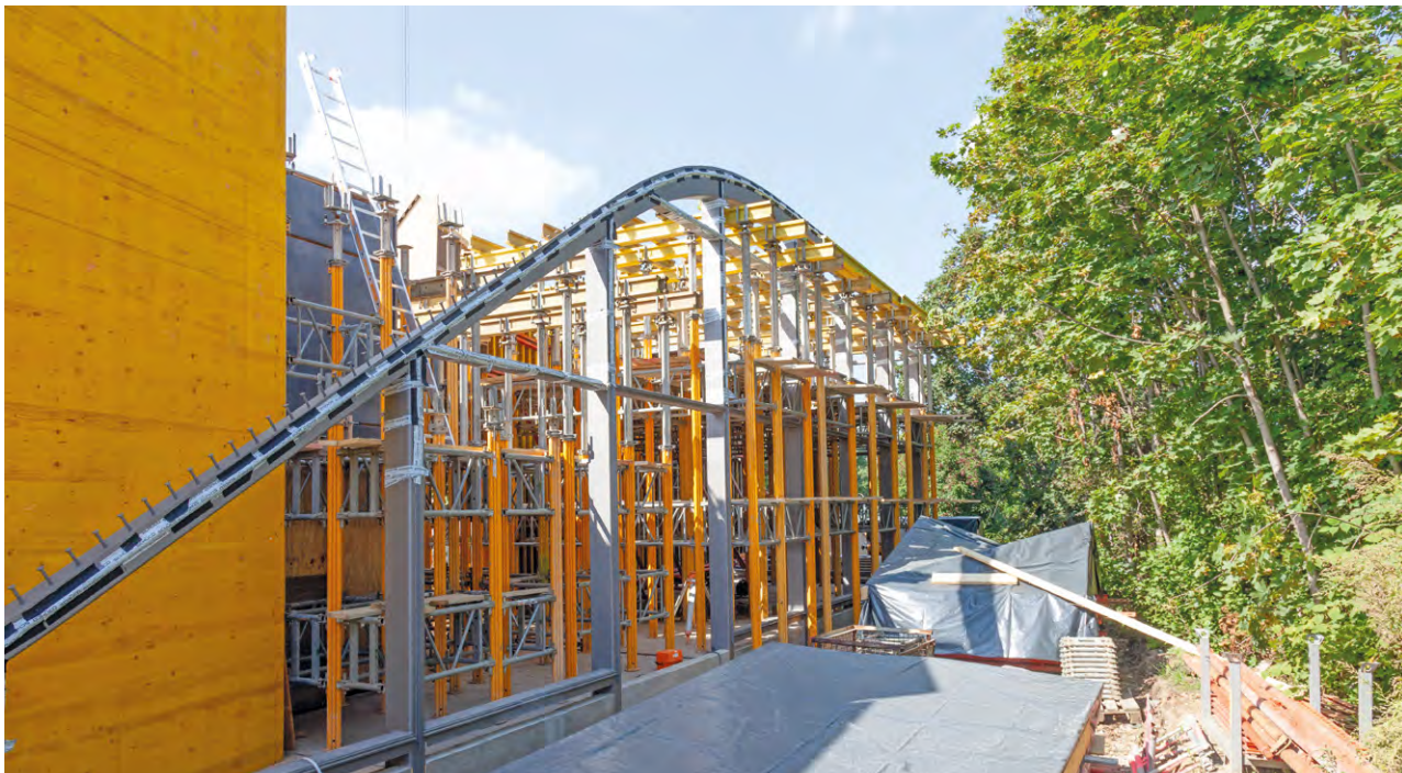
Aufbau der TWIST-Schalung.
