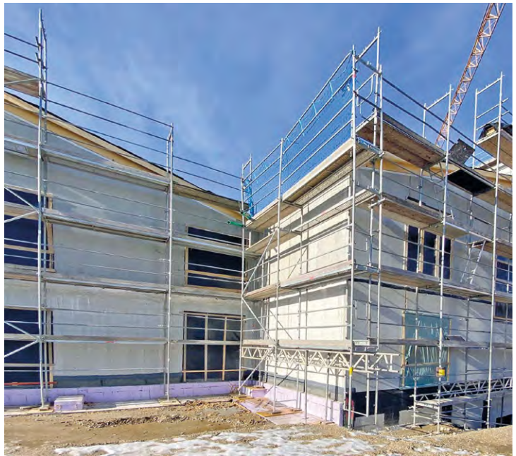
Der komplette Rohbau wurde im März 2021 fertiggestellt.
