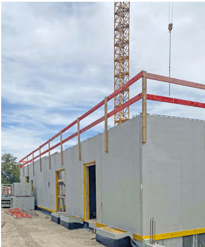
Der Rohbau Erdgeschoss konnte im August 2020 abgeschlossen werden.
