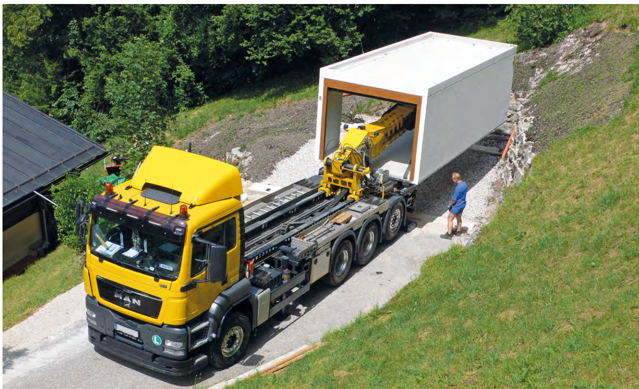
Aufstellung einer Betonfertiggarage mit Spezialfahrzeug.
