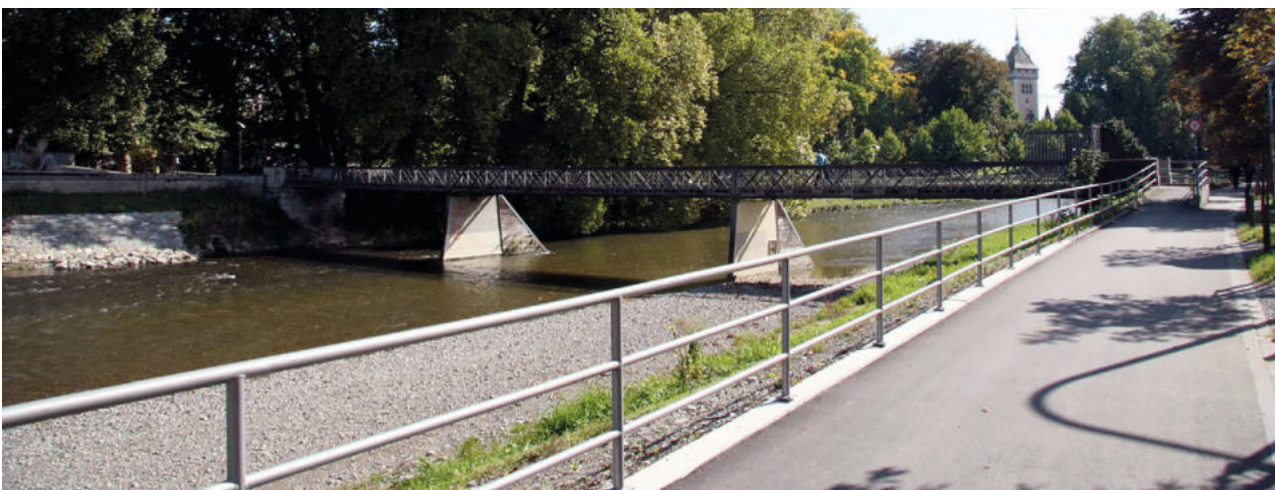
Der hölzerne Belag einer denkmalgeschützten Brücke in Zürich wurde erst durch Stahlbeton ersetzt, der im Laufe der Zeit altersbedingte Mängel aufwies. Im Zuge einer Sanierung kam später Carbonbeton zum Einsatz. Der Vorteil von Carbonbetonplatten: Sie sind ausgesprochen dünn.
