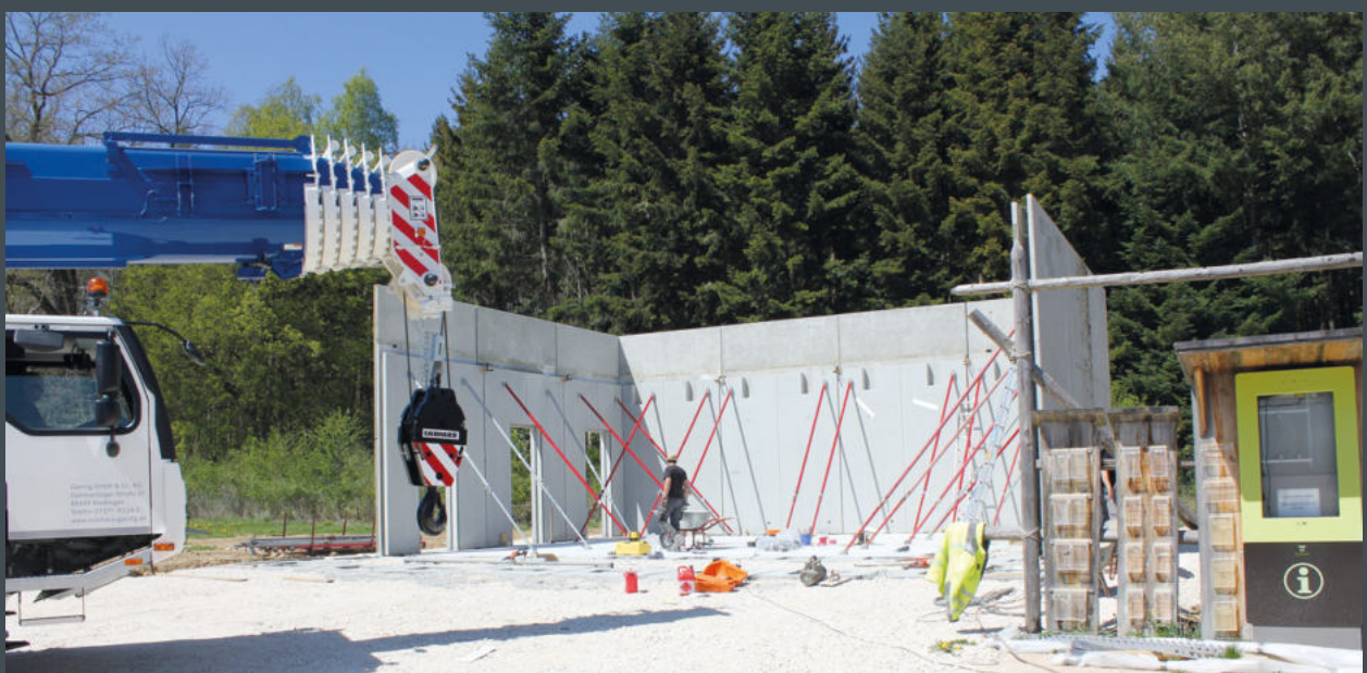
Die höchste Stufe des Recyclings: Demontierbare Betonfertigteile, die an anderer Stelle wieder aufgebaut werden, hier am Beispiel eines Pavillons, der auf der Bundesgartenschau in Heilbronn stand und derzeit in Meßkirch wieder aufgebaut wird.
