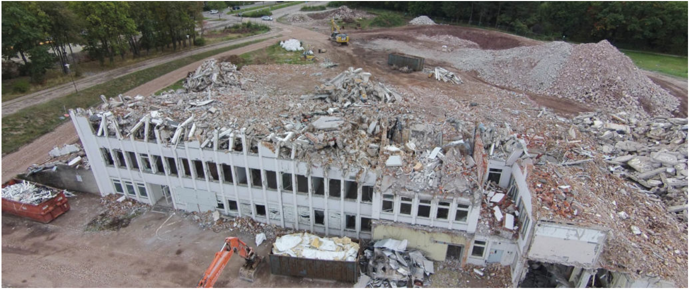
Selektiver Rückbau bietet gute Möglichkeiten für ein optimales Ergebnis beim Recycling.
