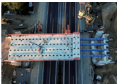
Montage der vorgefertigten Fahrbahnplatten über die A46.
