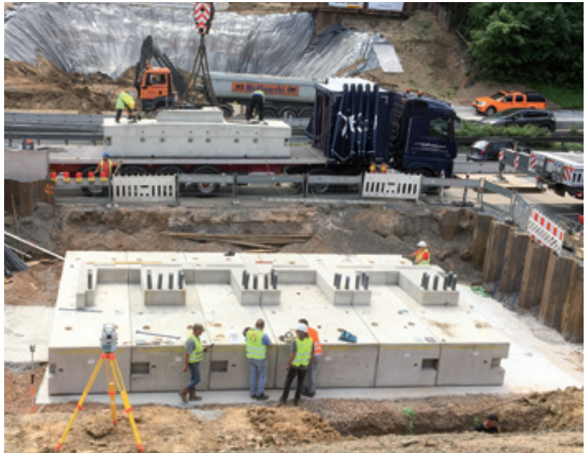
Auch die Fundamente für die Widerlager der Bauteilbrücke werden aus Betonfertigteilen zusammengespannt.
