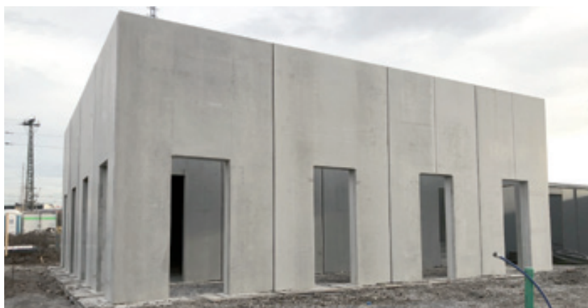
Just-in-Time-Lieferung: Der Veranstaltungspavillon aus Betonfertigteilen für die BUGA in Heilbronn.
