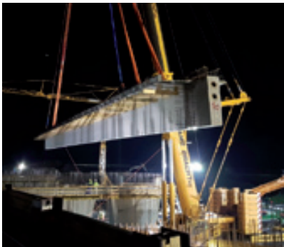
Montage der Brückenträger mit glatter Stegfläche.
