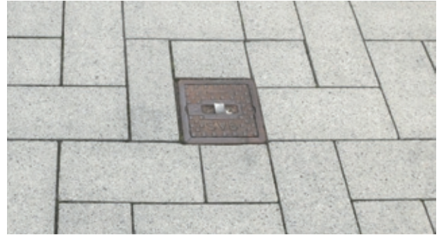
Bild 52: Passgenauer Anschluss an eine quadratische Straßenkappe durch geraden Zuschnitt im Nassschnittverfahren
