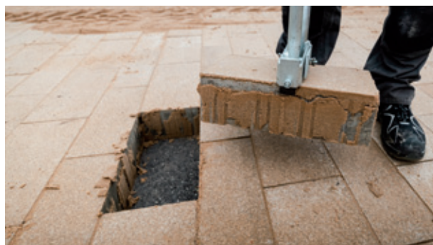
Bild 66: Vollständige Fugenfüllung nach maschinellem Einschlämmen
