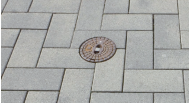
Bild 51: Passgenauer Anschluss an eine runde Straßenkappe durch Kernbohrverfahren
