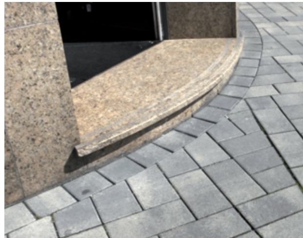
Bild 62: Positivbeispiel – Vorbildlich ausgeführter Anschlüsse an Schräge und Rundung im Bereich eines Hauseingangs
