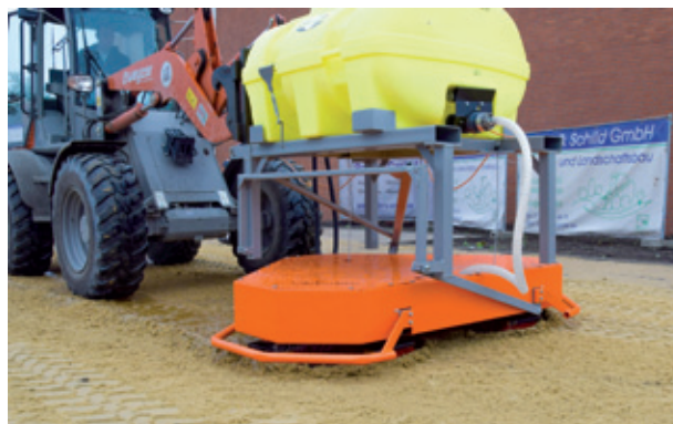
Bild 65: Maschinelles Einschlämmen der Pflasterdecke mit Hilfe der am Radlader montierten Einschlämmeinheit
