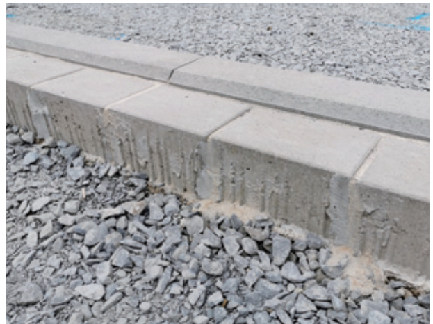
Bild 31: Seitlich verschlossene Fugenspalten einer einzeiligen Entwässerungsrinne zum Schutz des Fugenmörtels vor dem Auslaufen
