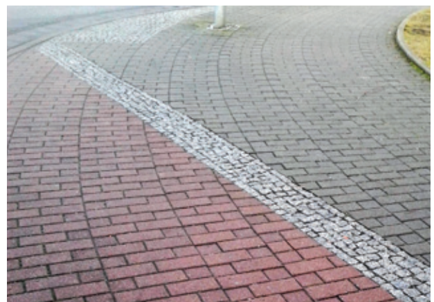
Bild 60: Odenwälder Verband aus Rechtecksteinen bei einem kurvenförmig verlaufenden Gehweg (Foto: Wellner)
