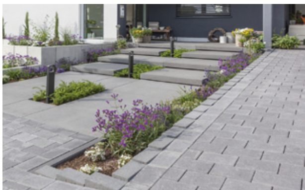
Beispielfotos 19 und 20: Stufenanlagen aus großformatigen Stufenplatten als Alternative zu Gebäudezugangstufen
