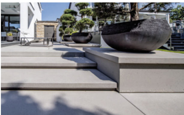
Beispielfotos 27 und 28: Stufenanlagen aus großformatigen Stufenplatten
