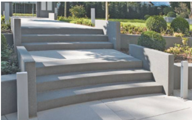
Beispielfotos 23 und 24: Treppen aus Blockstufen
