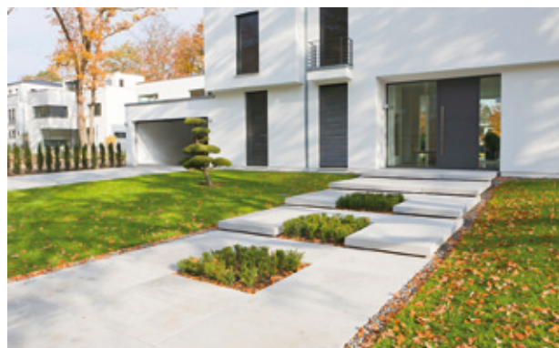
Beispielfotos 19 und 20: Stufenanlagen aus großformatigen Stufenplatten als Alternative zu Gebäudezugangstufen
