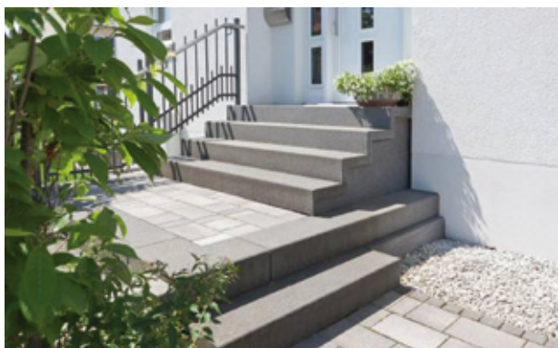
Beispielfotos 17 und 18: Geschlossene Gebäudezugangstreppe aus Winkelstufen
