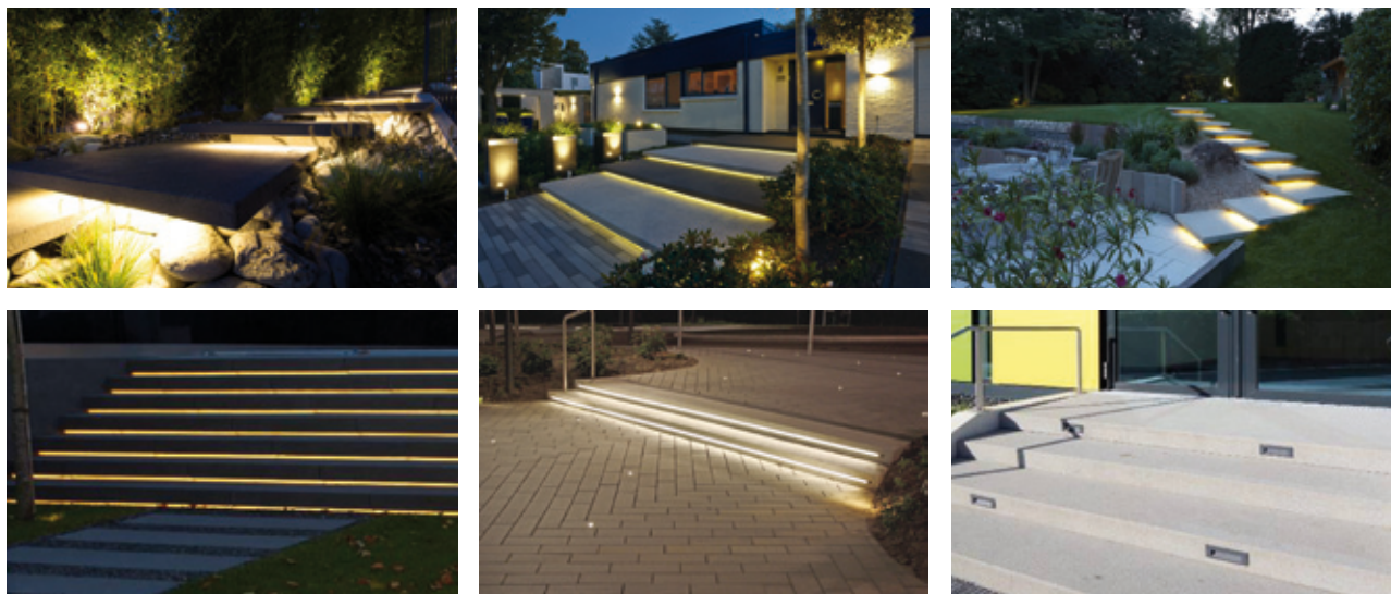
Beispielfotos 1 bis 6: Treppen und Stufenanlagen mit werkseitig in den Stufen integrierter Beleuchtung
