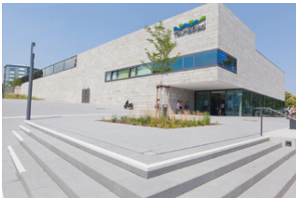
Beispielfotos 9 bis 12: Treppen und Stufenanlagen mit ins Gelände auslaufenden, visuell hervorgehobenen Stufen
