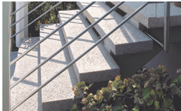
Beispielfotos 13 und 14: Offene Gebäudezugangstreppe aus bewehrten Trittstufen auf Treppenbalken
