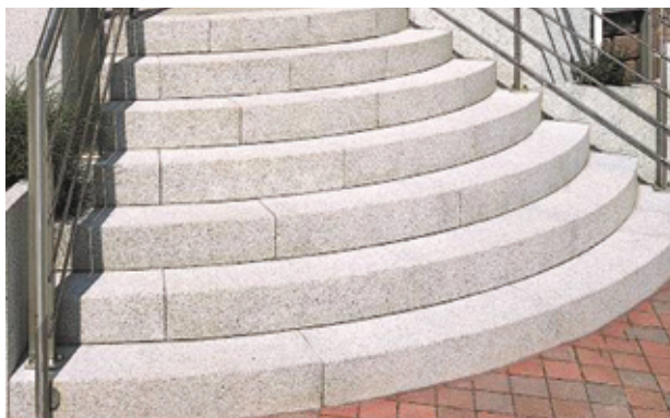
Beispielfotos 15 und 16: Geschlossene Gebäudezugangstreppe aus Blockstufen in Radienform
