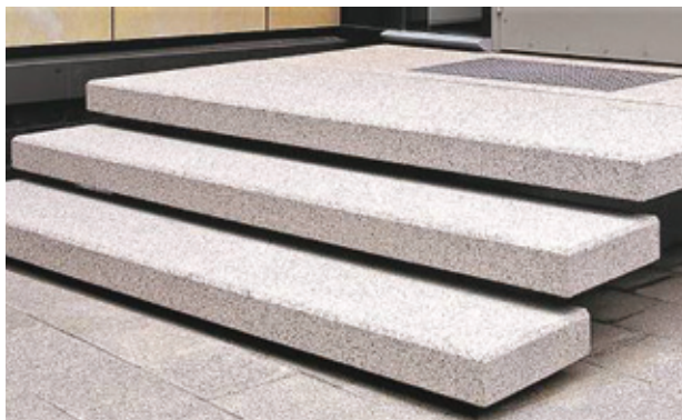
Beispielfotos 13 und 14: Offene Gebäudezugangstreppe aus bewehrten Trittstufen auf Treppenbalken
