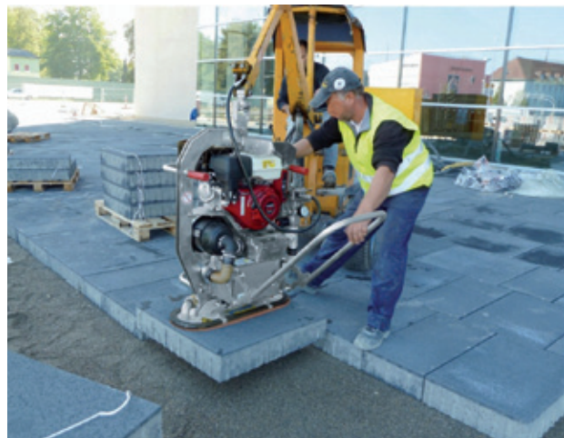
Bild 53: Verlegung von Großformaten aus Beton mittels Vakuum-Verlegegerät
