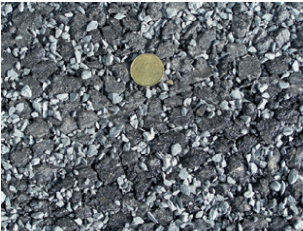
Bild 7: Mit Splitt abgestreute Oberfläche einer wasserdurchlässigen Asphalttragschicht zur Erzielung der Filterstabilität zum Bettungsmaterial
