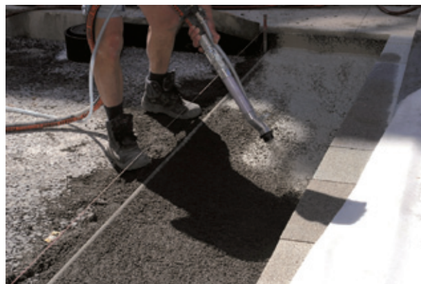
Bild 59: Aufspritzen eines Haftvermittlers auf den vorbereiteten Bettungsmörtel
