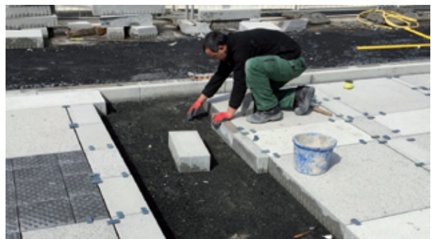
Bild 54: Fugenbleche aus Metall oder Kunststoff stellen die Einhaltung der geforderten Fugenbreite sicher
