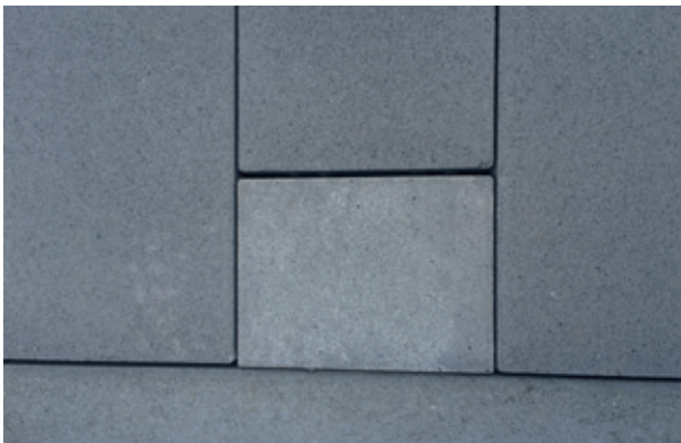
Bild 56: Unzureichend abgespültes, zuvor geschnittenes Passstück in einem Plattenbelag (weißliche Färbung durch Schneidschlämme)
