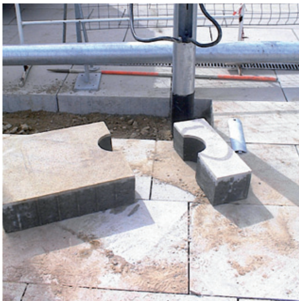
Bild 50: Beispiel für den Anschluss von Platten an einen Lichtmast durch Spezial-Nassschnittverfahren
