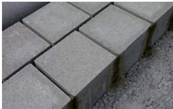
Bild 57: Seitlich verschlossene Fugenspalte einer Entwässerungsrinne vor dem Einbringen des Fugenmörtels
