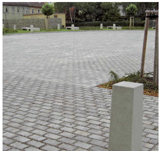
Bild 6: Versickerungsfähige Pflasterdecke mit aufgeweiteten Sickerfugen
