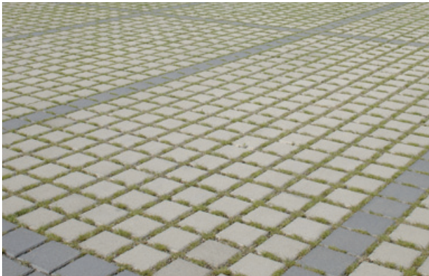
Bild 4: Begrünte Pflasterdecken aus Beton für den ruhenden Verkehr
