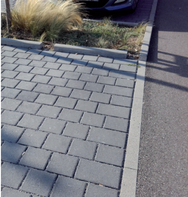
Bild 16: Versickerungsfähige Pflasterdecke mit Randeinfassung aus auf Lücke gesetzten Tiefbordsteinen
