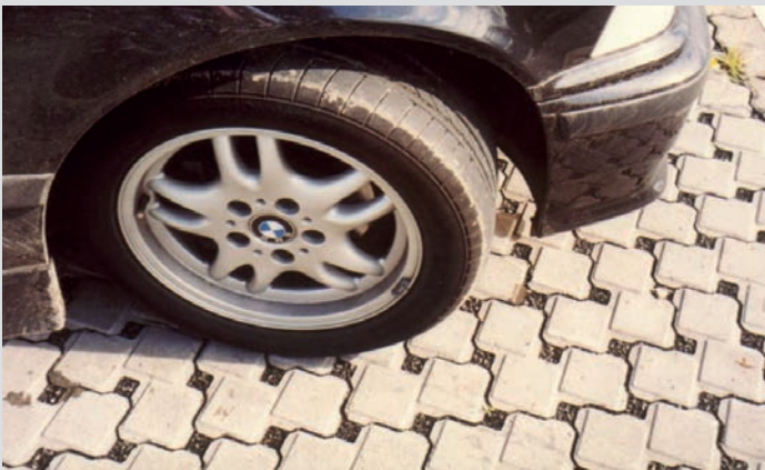
Bild 8: Versickerungsfähiges Verbundpflaster der Busparkflächen (Quelle: Borgwardt)
