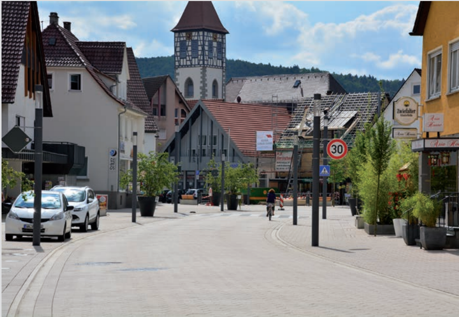
Bild 1: In Pflasterbauweise umgestaltete L 1080 in der Ortsdurchfahrt Rudersberg (Quelle: PRR)
