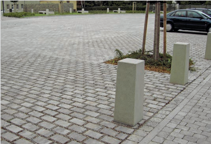
Bild 6: Befestigung von Pkw-Stellflächen mit Sickerfugenpflaster aus Beton (Quelle: SLG)
