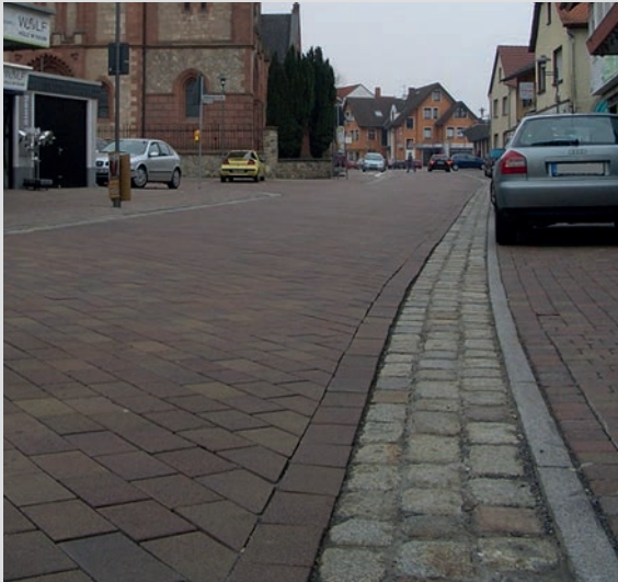
Bild 4: Innerortsstraße mit einer lärmarmen Betonpflasterdecke im hessischen Rödermark/Ober-Roden (Quelle: SLG)
