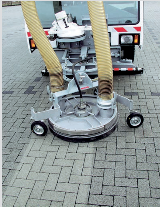
Bild 9: Reinigung einer versickerungsfähigen Betonpflasterfläche mit speziell entwickeltem Spül-Saug-Verfahren (Quelle: SLG)
