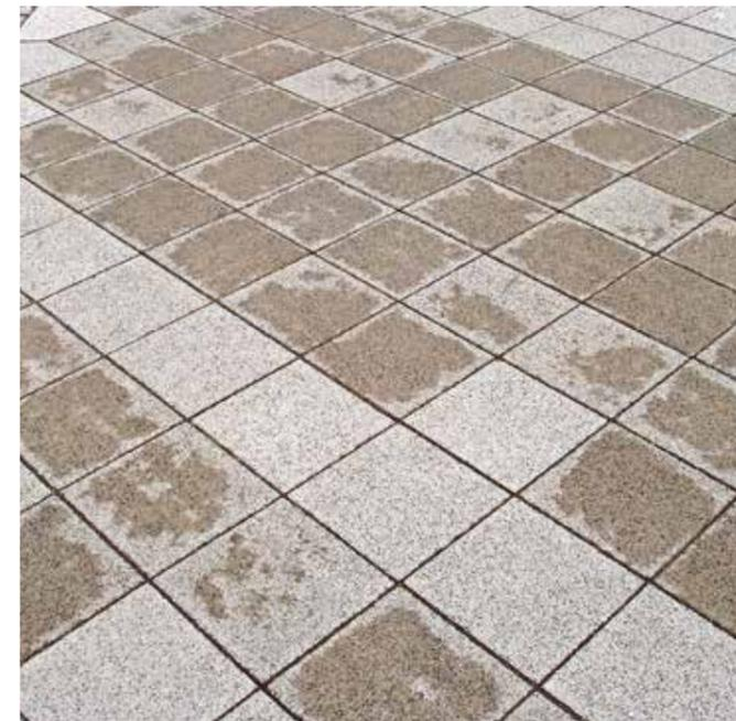
Abbildung 2: Ungleichmäßige Abtrocknung von Betonplatten.
