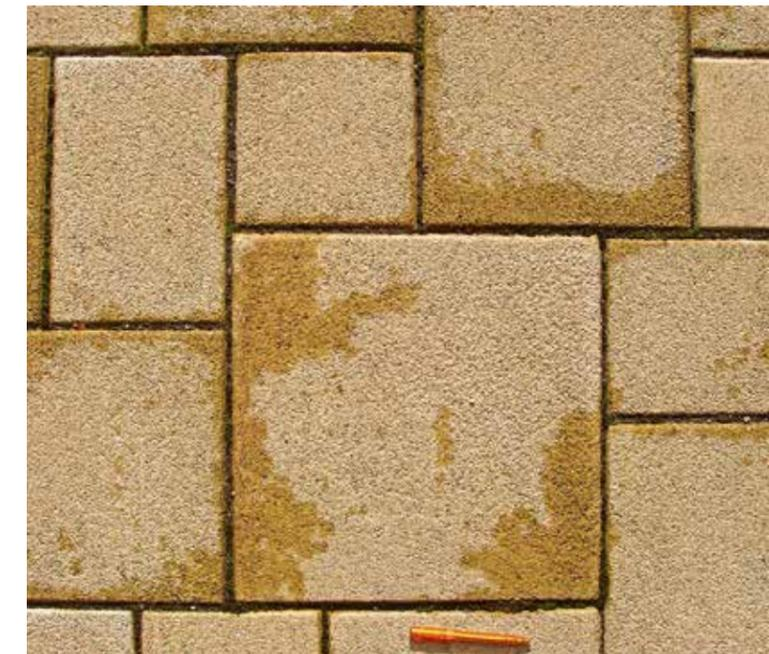
Abbildung 3: Ungleichmäßige Abtrocknung von farbigen Betonpflastersteinen.
