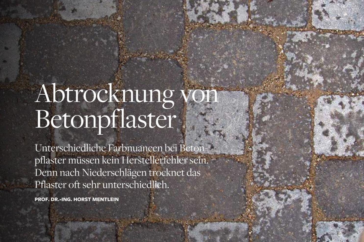
Abbildung 1: Ungleichmäßige Abtrocknung von grauen Betonpflastersteinen.
