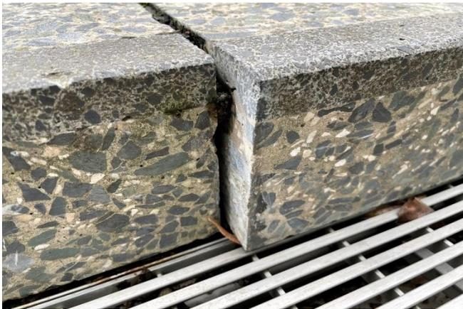
Bild 1: Verschobene Stufe (Quelle: Betonverband SLG)
