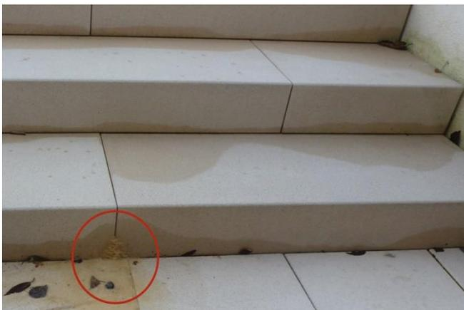
Bild 2: Ausblühungen (Quelle: Betonverband SLG)
