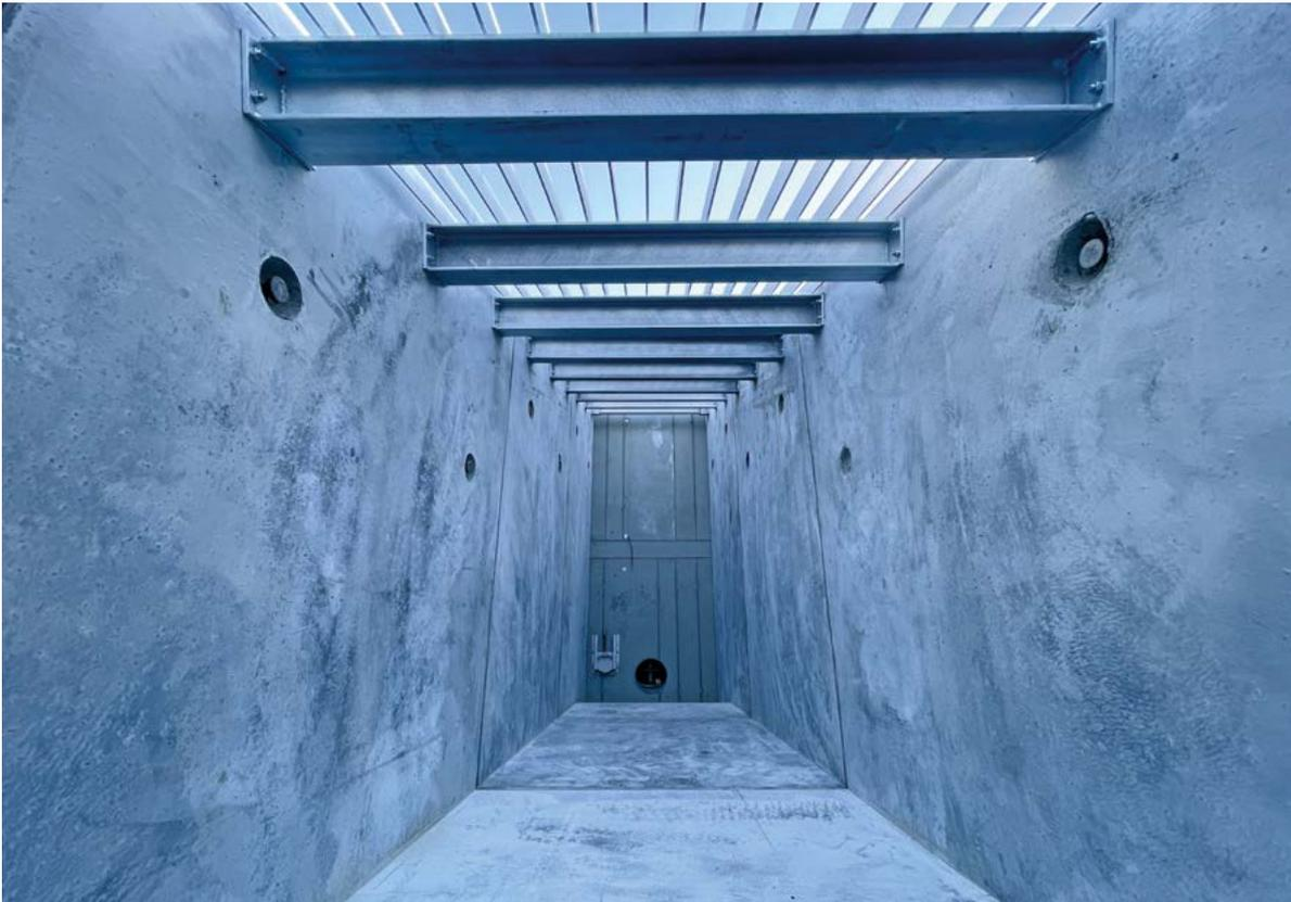
Die Hochwasserentlastung des Rückhaltebeckens erfolgt in zwei Stufen. Nach Erreichen des Vollstaus bei einem 100-jährlichen Hochwasserereignis springt die erste Entlastung am Auslassbauwerk über den rückwärtigen Schacht an.
