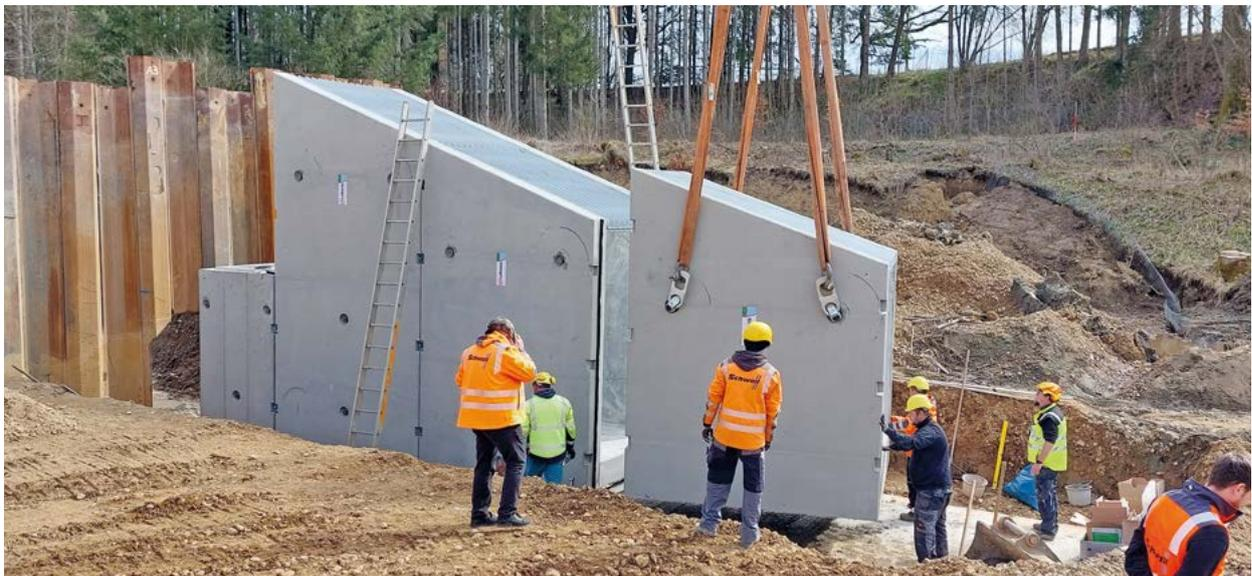
Wegen der besonderen geologischen Verhältnisse wurde das komplette Bauwerk auf einer Pfahlgründung errichtet. Hierfür wurden neun Elemente auf einer 30 cm starken Fertigteilplatte montiert.
