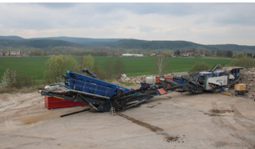
Mobile Bauschutttaufbereitungsanlage mit Brecher, Sortierung und Siebstation.
