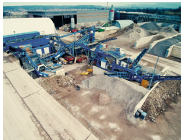
Stationäre Bauschutttaufbereitungsanlage der Heinrich Feeß GmbH & Co. KG in Kirchheim/Teck.
